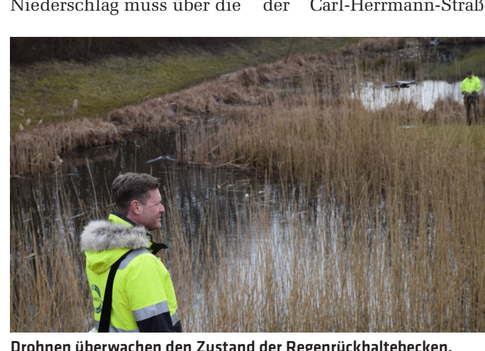
Drohnen überwachen den Zustand der Regenrückhaltebecken.
